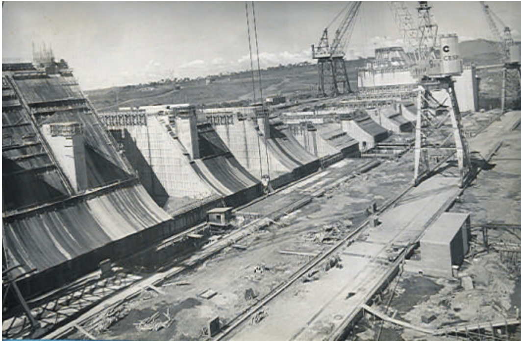
Figura 04-Superfície do Vertedouro de Ilha Solteira, sem o emprego de Armadura
