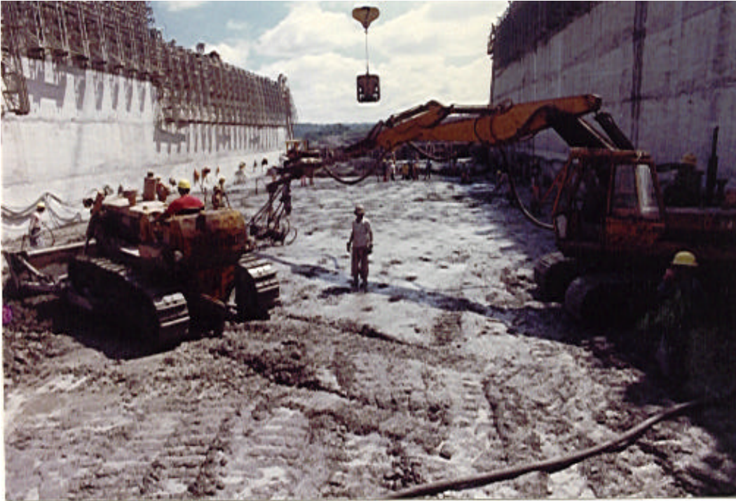
Figura 31- A utilização de camadas extendidas em Itaipu
