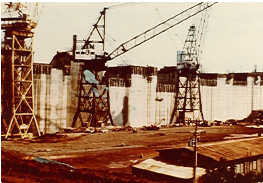
Figura 15- Guindastes Tipo-Portuário, para o lançamento do concreto
