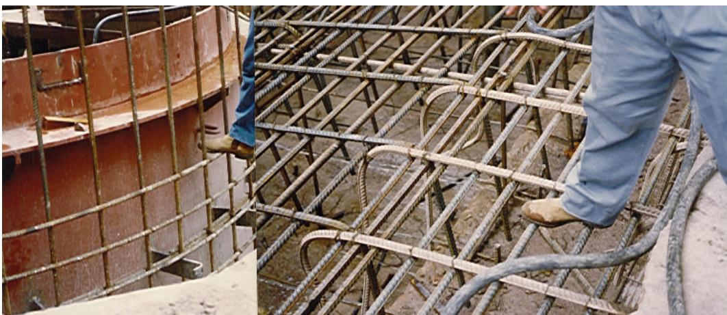
Figura 35- Armadura para o Concreto Envoltório de um Tubo de Sucção, e Soleira de um Sucção, em um Projeto no Exterior
