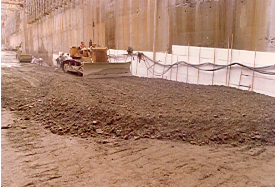
Figura 33- Concreto Rolado aplicado inicialmente em Itaipu.
