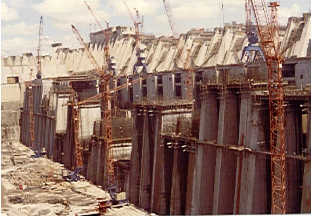
Figura 16- Guindaste de mesa baixa, em substituição ao do tipo portuário
