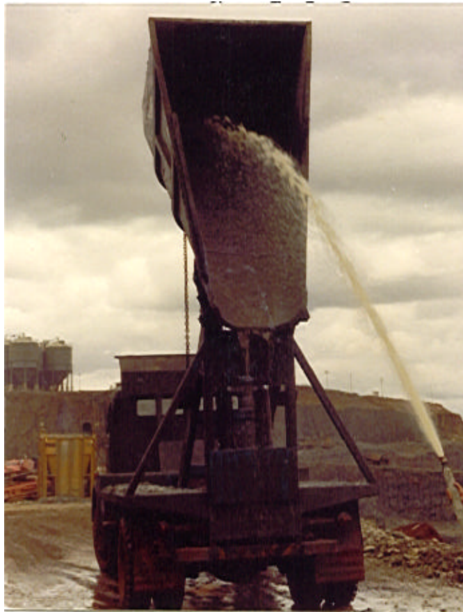
Figura 19- Dumpretes, de descarga alta, substituindo as caçambas sobre carretas.
