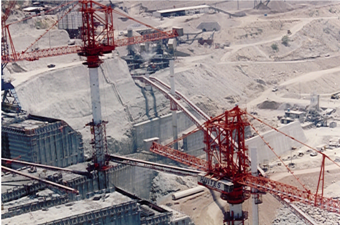
Figura 39- Sistema de Correias Transportadoras, para transporte do Concreto desde as Centrais até a colocação através de Tower-Belt-HUITES-MÉXICO, que possibilitou a execução de 248.200m 3 , em um só mês (outubro/94) , com um pico diário de 13.300m 3 .
