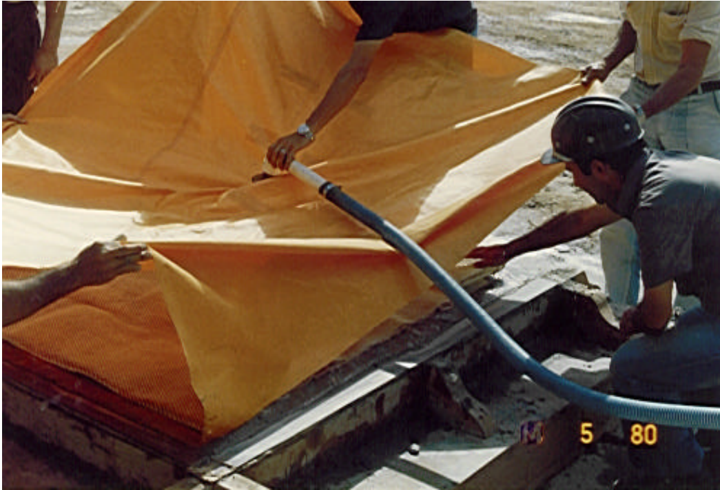
Figura 27- O concreto com tratamento a vácuo, utilizado em Emborcação
