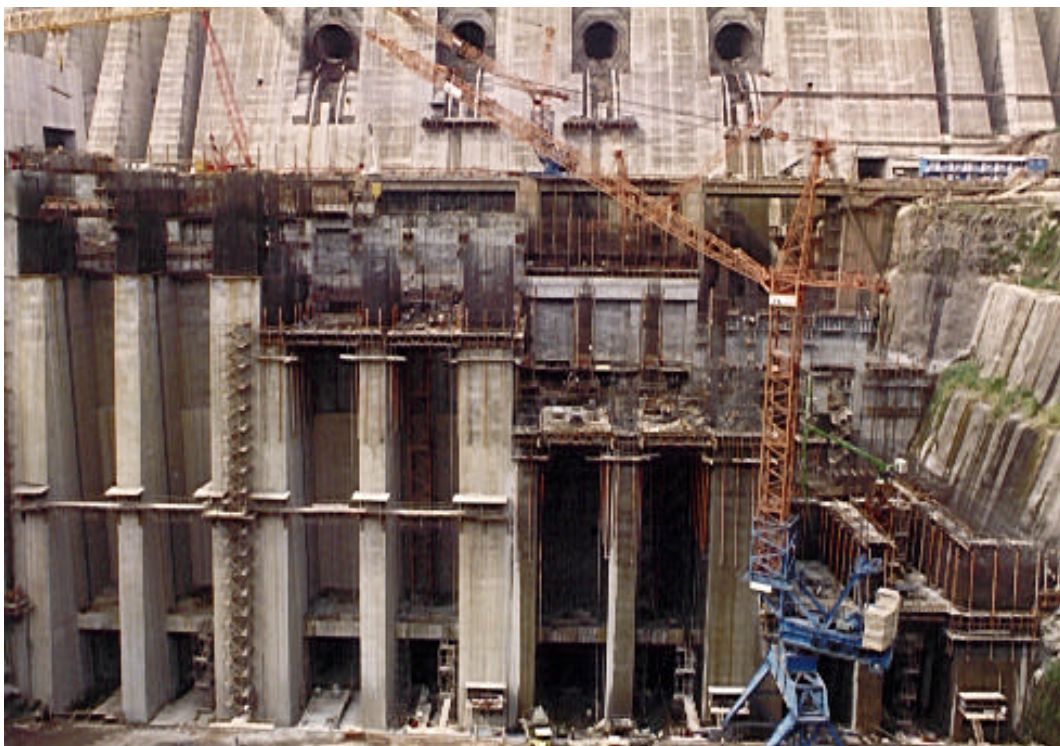
Figura 30- Formas deslizantes intensamente utilizadas em Itaipu
