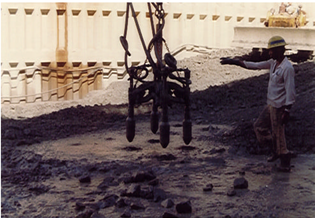
Figura 17- Vibradores acoplados à lança de retro-escavadora.
