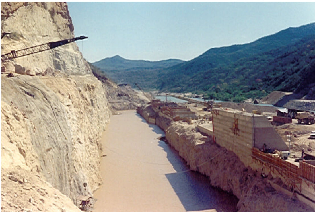
Figura 40- Creter Crane para a colocação de concreto-HUITES-MÉXICO.
