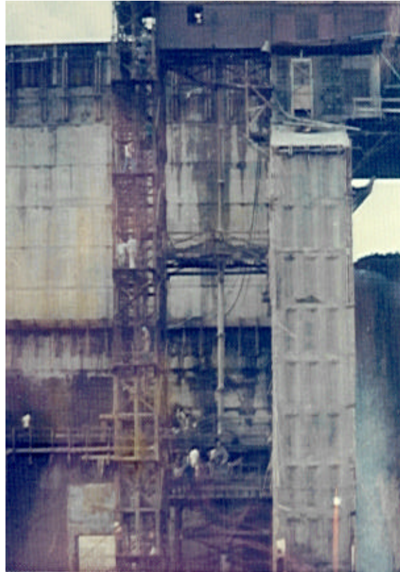
Figura 22- Transporte vertical do concreto através de tubulação.
