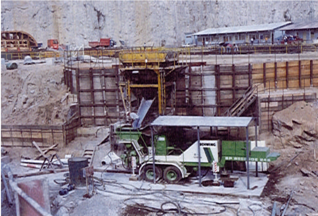
Figura 41- Bomba de concretagem, para concreto com agregado de D_{max}=80\text{mm} -XINGÓ, utilizando misturas com menos de 230\text{ Kg/m}^3 de aglomerante.
