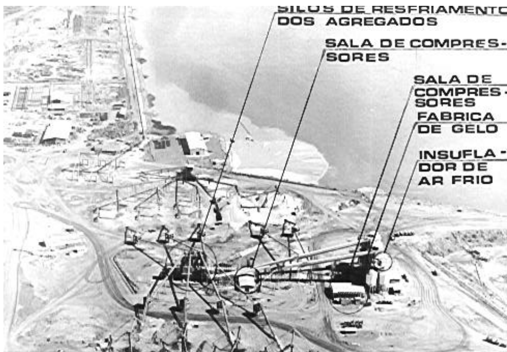
Figura 21- Sistemas de refrigeração de agregados e concreto
