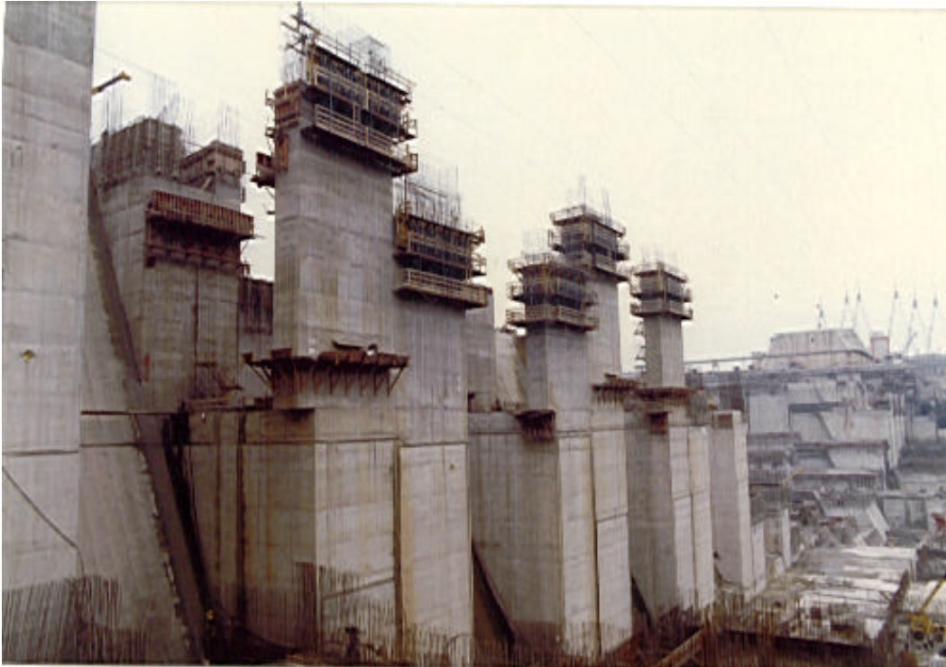
Figura 29- Formas auto-ascensionáveis utilizadas em Itaipu
