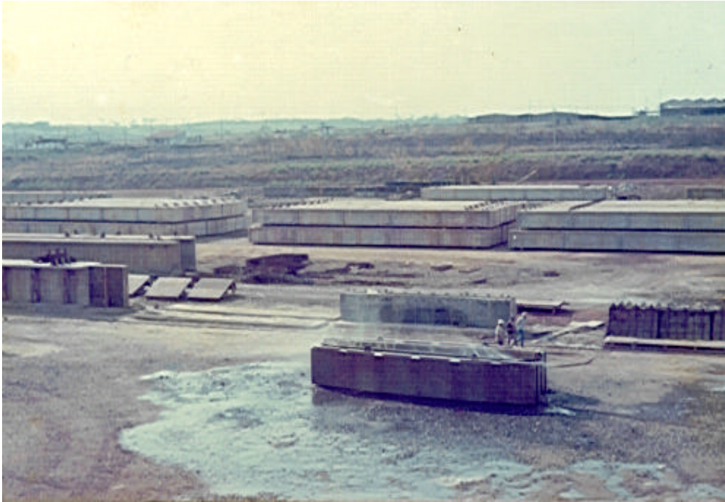
Figura 23- O emprego de pré-moldados em Ilha Solteira.
