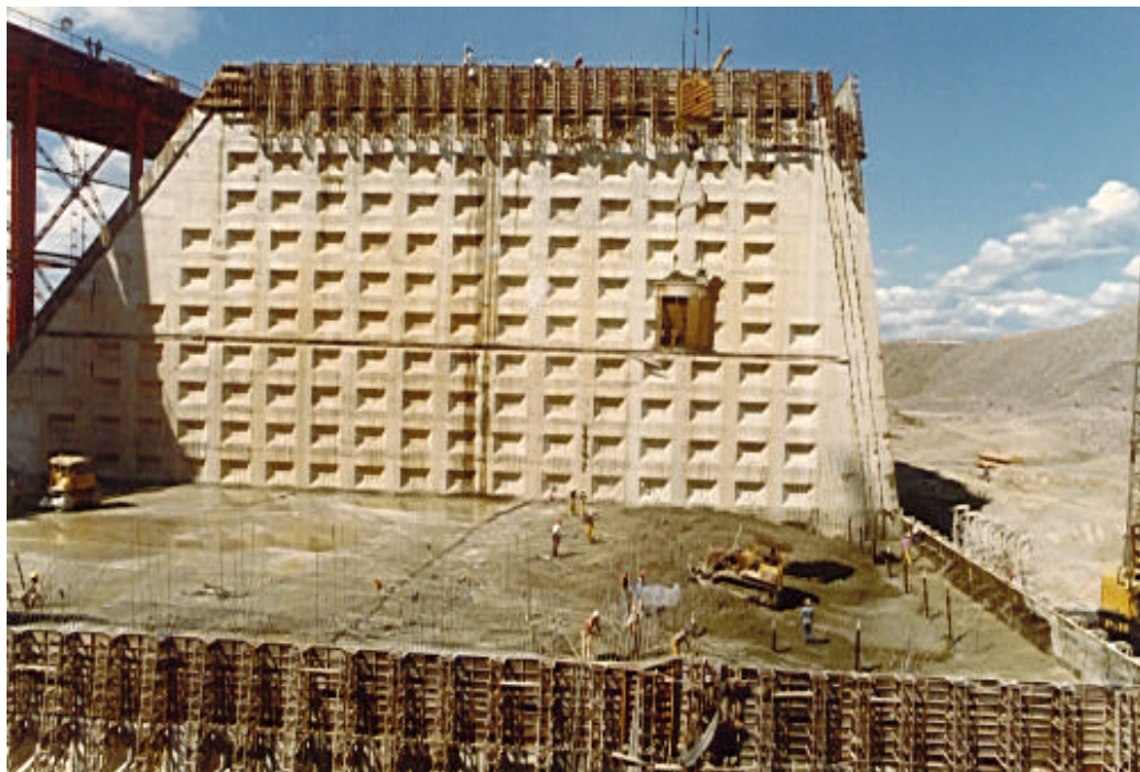
Figura 11- Concreto de Face, sem Armadura- Tucurui
