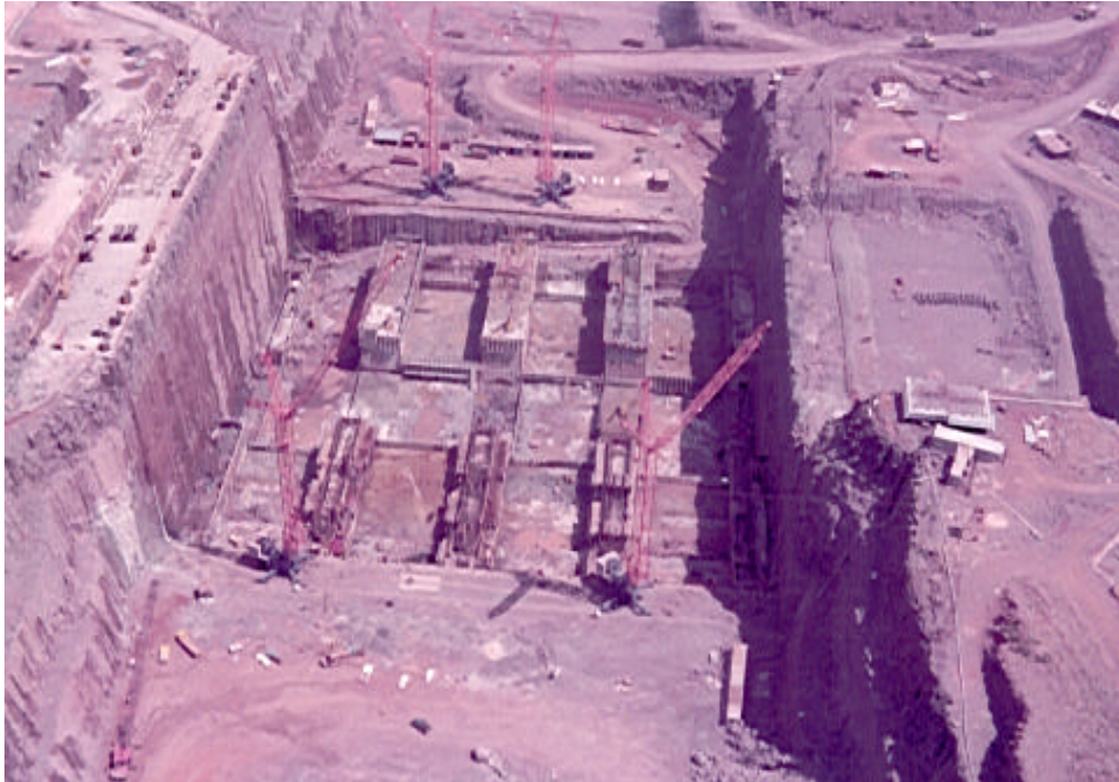
Figura 36- Armadura ao redor de galeria, prática contestada e questionada.
