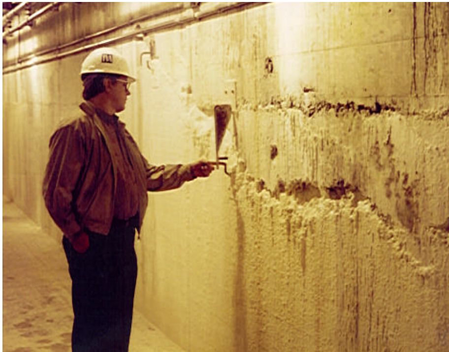
Figura 03- Barragem de Fontana-Fissuras Internas- Estados Unidos
