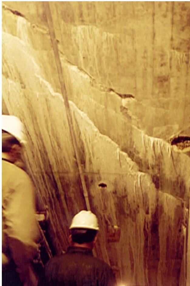
Figura 03- Barragem de Fontana-Fissuras Internas- Estados Unidos
