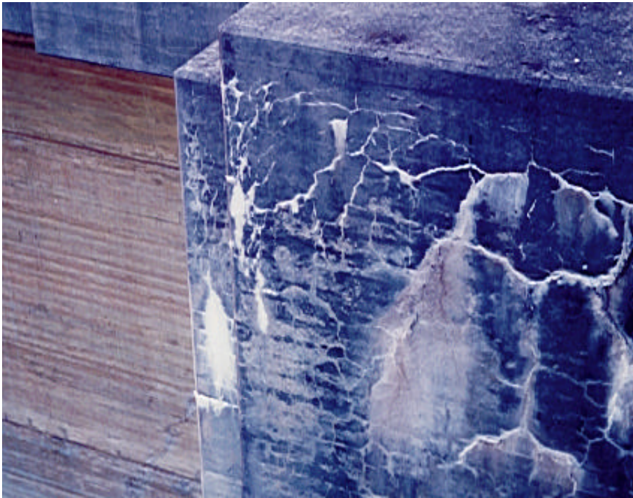
Figura 05- Barragem de Fontana- Fissuras na região do Vertedouro- Estados Unidos
