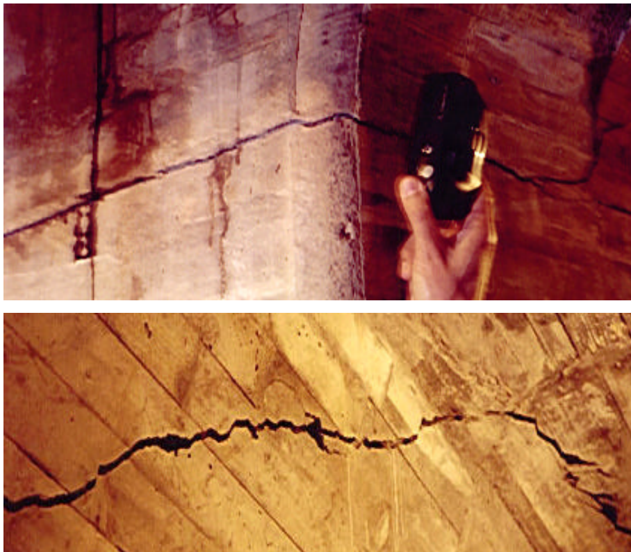
Figura 02 – Fissuras internas na Barragem de Hiwassee- Estados Unidos
