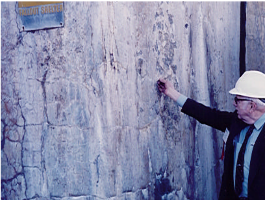
Figura 06- Barragem de Chickmauga- Fissuras na região das eclusas- Estados Unidos
