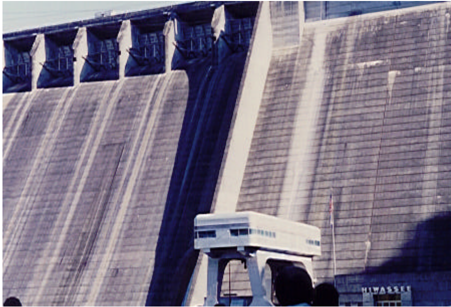
Figura 01- Vista da Barragem de Hiwassee- Estados Unidos, durante a visita técnica do “ Second International Conference on Alkali- Aggregate Reactions in Hydroelectric Plants and Dam ”-Outubro/1995.
