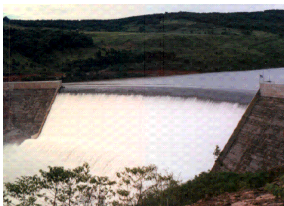
FIGURA 03- BARRAGEM DA DERIVAÇÃO DO RIO JORDÃO-(COPEL-PR-BRASIL)
