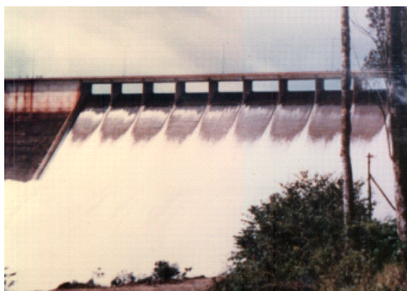
FIGURA 02- BARRAGEM DE URUGUA-I (ARGENTINA)
