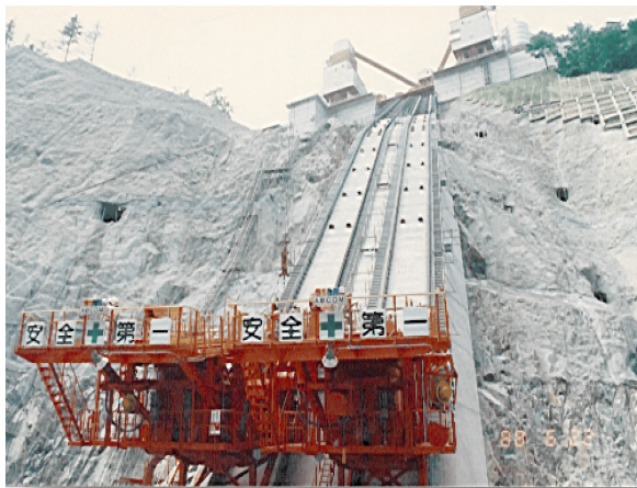
Figura 06- Rampa de acesso para transporte do CCR e apoio de equipamentos-Japão.
