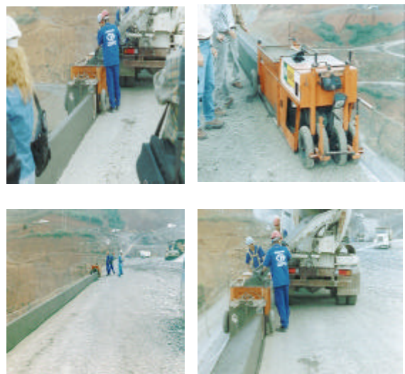
Figura 13- Equipamento para moldagem de paramento.
