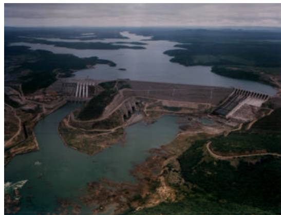
Figura 16- Proteção na região de jusante da Barragem de enrocamento, de Xingó.
