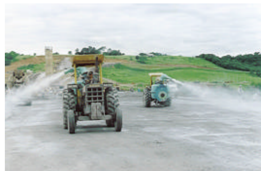
Figura 09- Vaporizadores agrícola adaptados para a Cura do CCR, em Salto Caxias.
