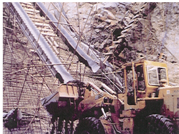
Figura 05- Tubulação para transporte do CCR em obra na China.
