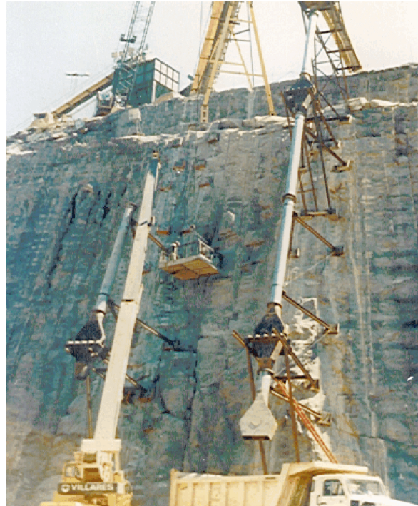
Figura 04- Tubo para transporte vertical do CCR, em Capanda.
