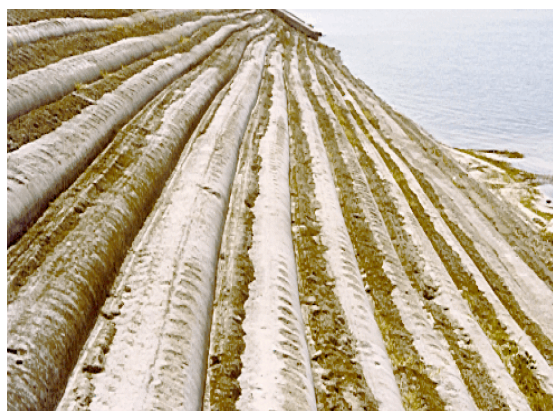
Figura 20- Aspecto do Solo-Cimento usado como proteção de talude, nos Estados Unidos.
