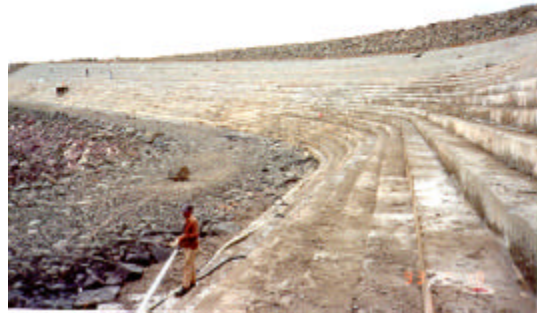
Figura 15- Proteção em CCR, na barragem de Porto Primavera.
