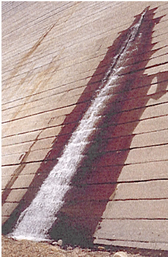
Figura 14- Fissura na barragem de Upper Stillwater, decorrente da geração térmica.
