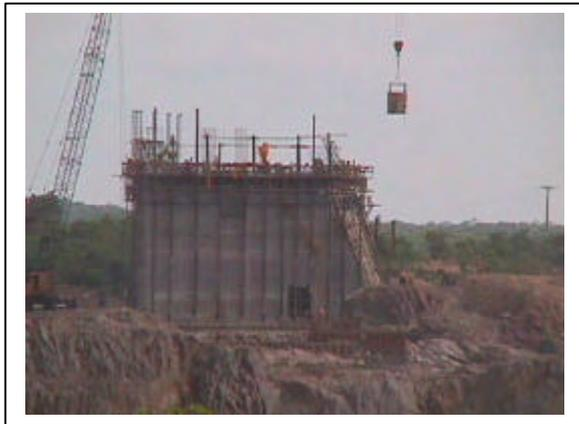
**Muro Direito- Hidroelétrica de Manso- executado em concreto massa e forma deslizante**
