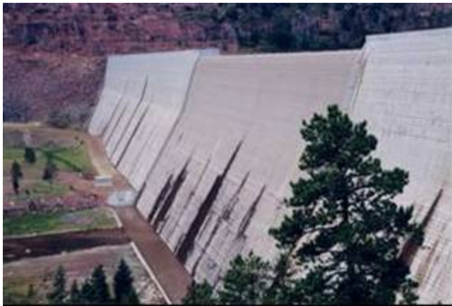
Presas de Primera Generación construídas en CCR, cuando no se prestaba atención adecuada al espaciamiento de Juntas de Contracción y Permeabilidad de Aguas Arriba
