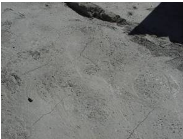
Presa donde se observaron fisuras por asentamiento plástico y porosidad en los concretos de regularización, por causa de compactación (vibración) deficiente
