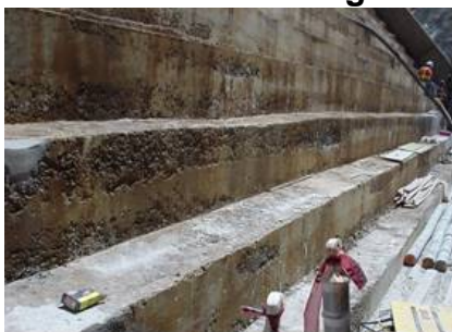
Presas donde no dio atención adecuada al Sistema de Impermeabilización del Paramento de Aguas Arriba y al Tratamiento de las Juntas de Construcción
