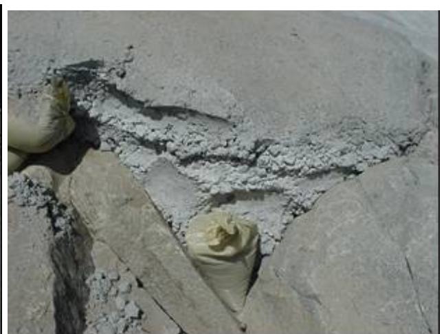
Presa donde se observaron fisuras por asentamiento plástico y porosidad en los concretos de regularización, por causa de compactación (vibración) deficiente
