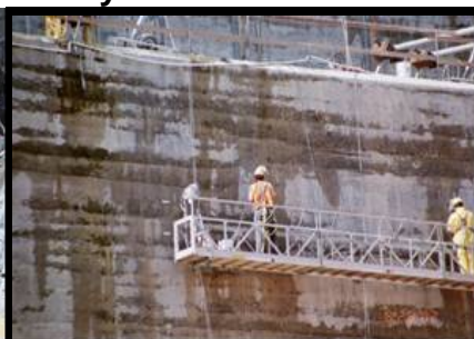
Presas donde no dio atención adecuada al Sistema de Impermeabilización del Paramento de Aguas Arriba y al Tratamiento de las Juntas de Construcción
