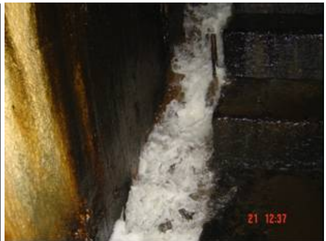
Presas donde no dio atención adecuada al Sistema de Impermeabilización del Paramento de Aguas Arriba y al Tratamiento de las Juntas de Construcción
