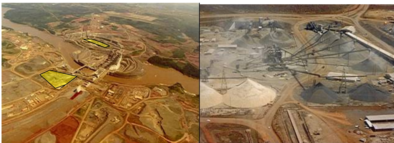
Areas de los Sistemas de Producción e Beneficiamiento de Agregados e de Pré-enfriamiento de los Agregados, en ambas márgenes del Rio Paraná, para la ejecución de la Obra
