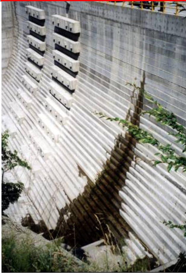
Presas donde no se dio atención adecuada a las Juntas de Contracción y de Construcción, posteriormente se realizaron reparaciones con Membrana de PVC
