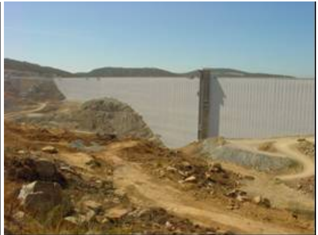
Presa donde no se dio atención adecuada a la vibración del GERRC del Paramento de Aguas Arriba, posteriormente se colocó adicionalmente una Membrana de PVC
