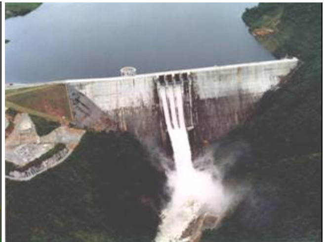
Presas de Primera Generación construídas en CCR, cuando no se prestaba atención adecuada al espaciamiento de Juntas de Contracción y Permeabilidad de Aguas Arriba
