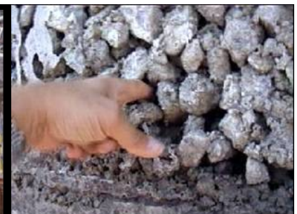
Presas donde no dio atención adecuada al Sistema de Impermeabilización del Paramento de Aguas Arriba y al Tratamiento de las Juntas de Construcción
