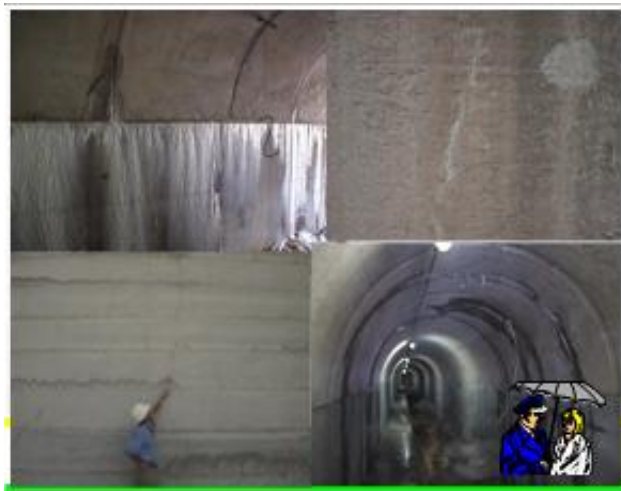
Presas de Primera Generación construídas en CCR, cuando no se prestaba atención adecuada al espaciamiento de Juntas de Contracción y Permeabilidad de Aguas Arriba
