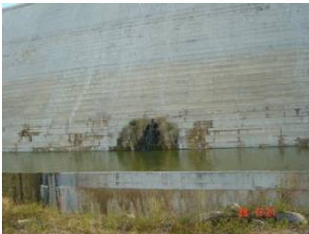
Presas donde no dio atención adecuada al Sistema de Impermeabilización del Paramento de Aguas Arriba y al Tratamiento de las Juntas de Construcción
