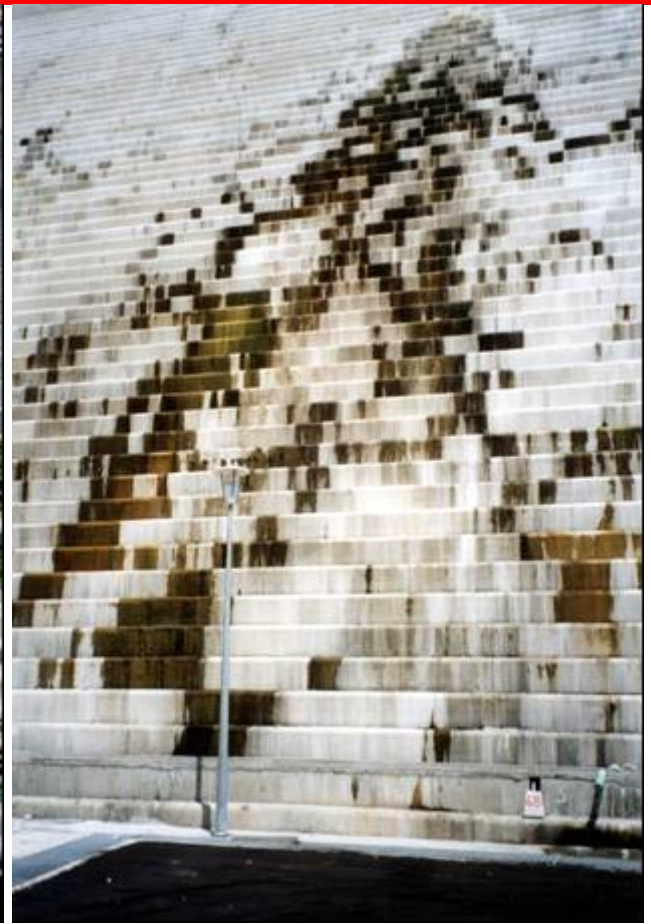
Presas donde no se dio atención adecuada a las Juntas de Contracción y de Construcción, posteriormente se realizaron reparaciones con Membrana de PVC
