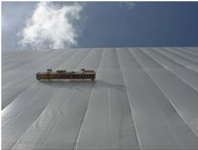
Presa donde no se dio atención adecuada a la vibración del GERRC del Paramento de Aguas Arriba, posteriormente se colocó adicionalmente una Membrana de PVC
