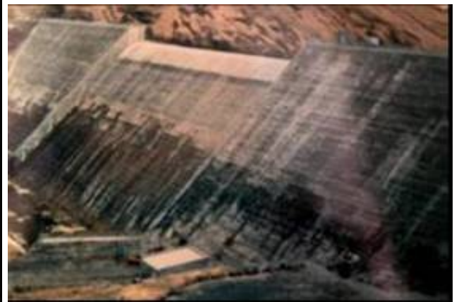
Presas de Primera Generación construídas en CCR, cuando no se prestaba atención adecuada al espaciamiento de Juntas de Contracción y Permeabilidad de Aguas Arriba
