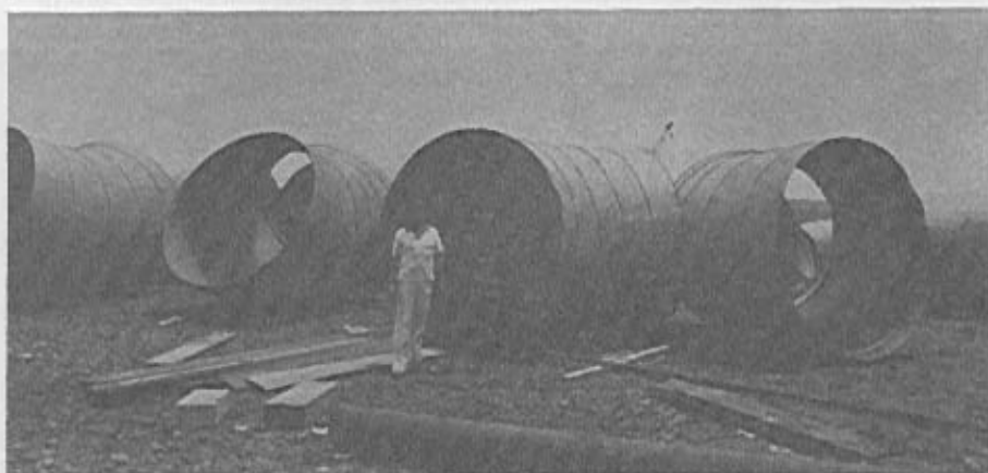
Parágrafo 40 – Duto Central de retorno de ar frio dos silos da Central de Concreto. Preparação para montagem. Diâmetro 2,4 m – UHE-Três Irmãos.
