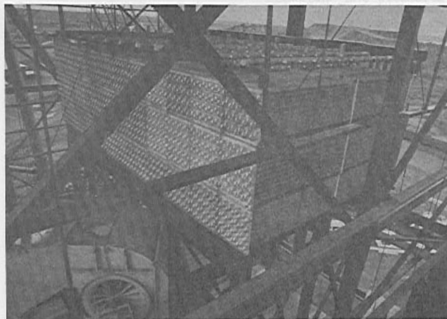
Figura 41 – Montagem de Resfriador de Ar com 9000 m 2 e Ventilador de 450 HP. UHE – Três Irmãos.
