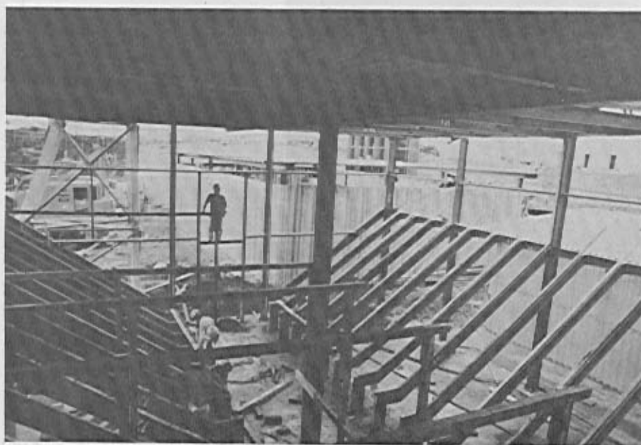
Figura 48 – Construção e Montagem de Depósito de Gelo – Tipo Gravidade – UHE – Nova Avanhandava.
