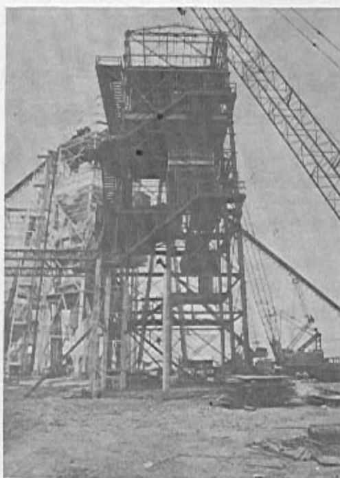
Figura 67 – Fase de Montagem das Estruturas Metálicas da Fábrica de Gelo e Central de Concreto – U.H.E. – Três Irmãos.
