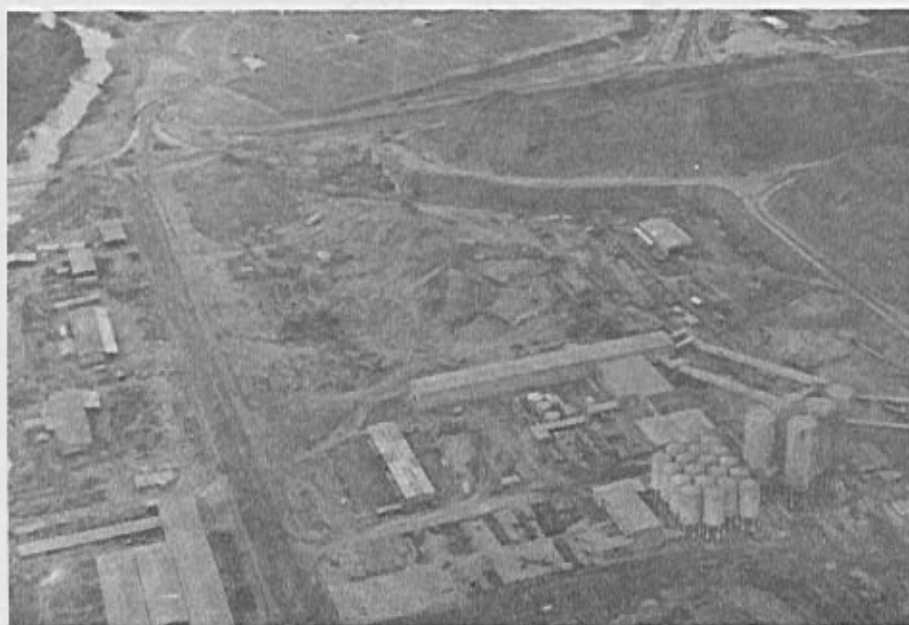
Figura 53 – Instalações de Refrigeração do Concreto na Obra de Tucuruí – Eletro-norte
