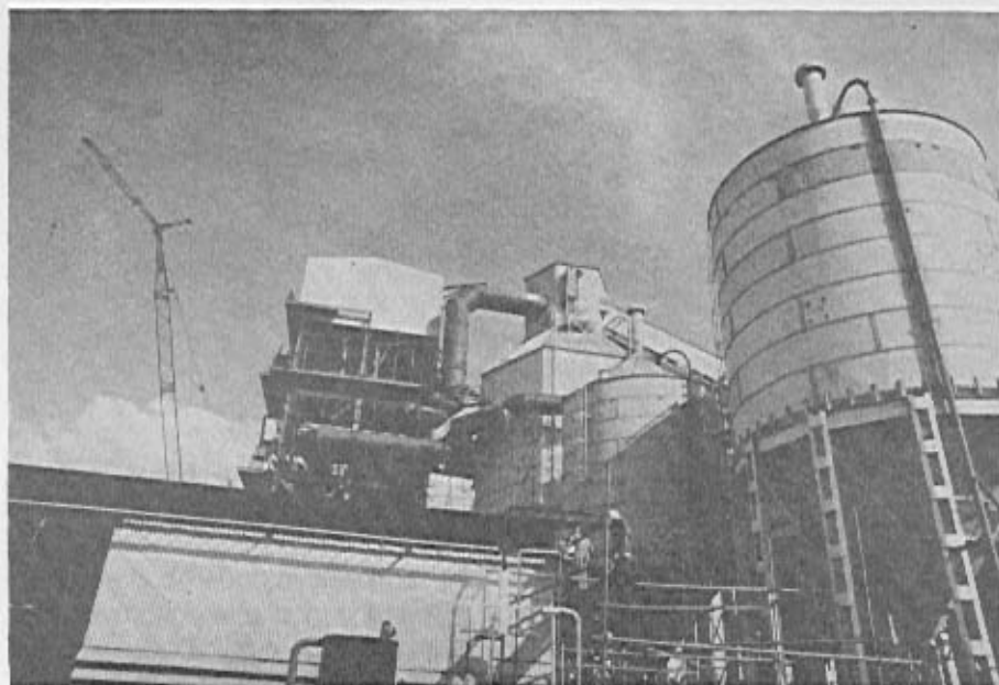
Figura 37 – Montagem dos Dutos de Recirculação de Ar Frio – UHE – Porto Primavera.
