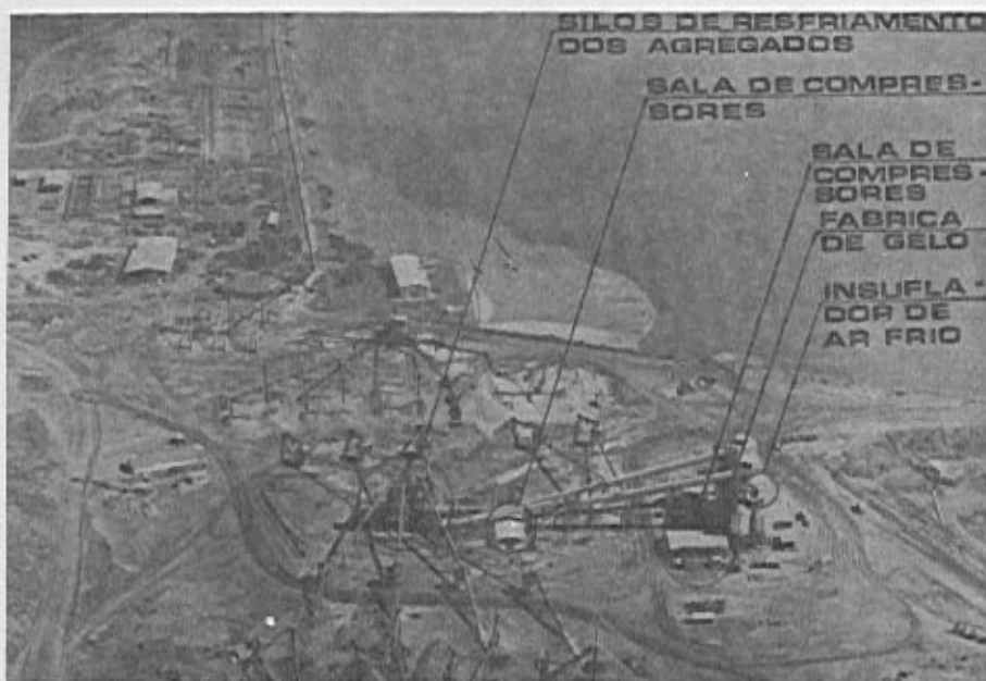
Figura 52 – Ilustrações da Refrigeração na Obra da Barragem de Ilha Solteira.
