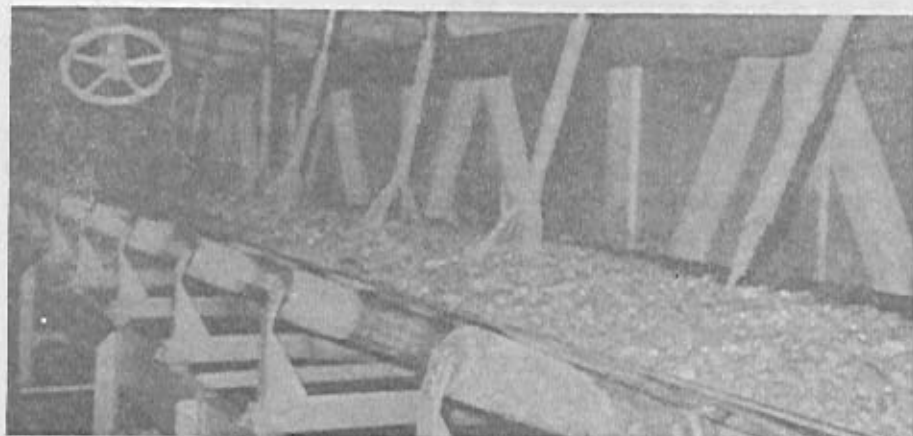
Figura 23 – Bicos Aspersores de Água Gelada, sobre os Agregados Transportados pela Correia-UHE-Água Vermelha.
