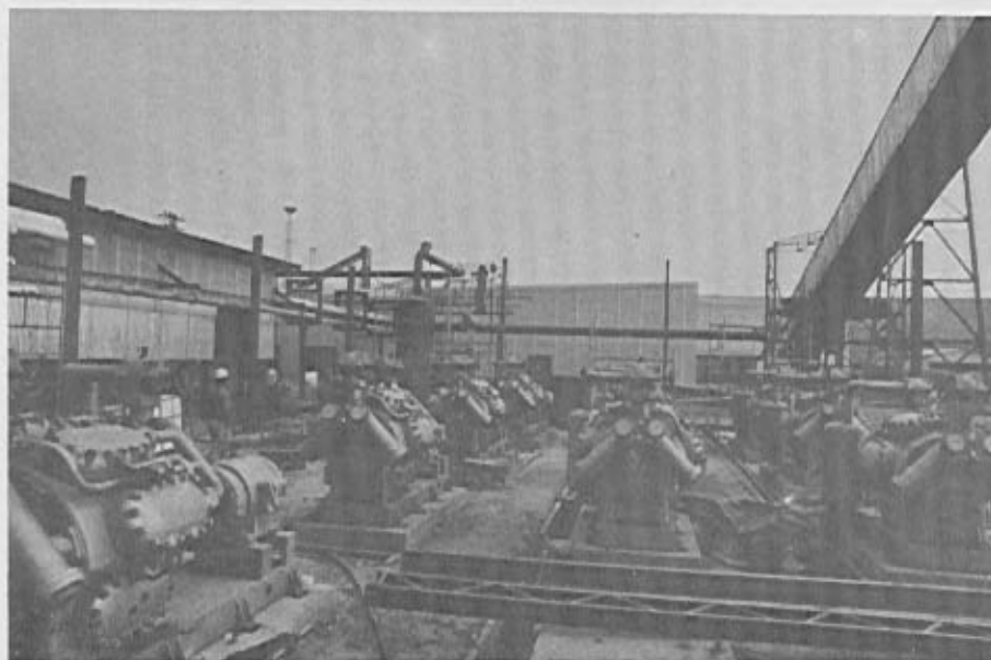
Figura 55 – Fase de Montagem dos Compressores Multicilindro – UHE – Tucuruí
