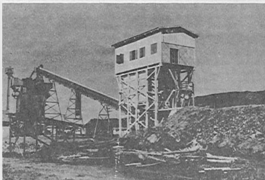
Figura 7 – Instalação Pioneira para Fabricação de Gelo utilizado nos Ensaio de Pré-Resfriamento na UHE – Jupia – 1966
