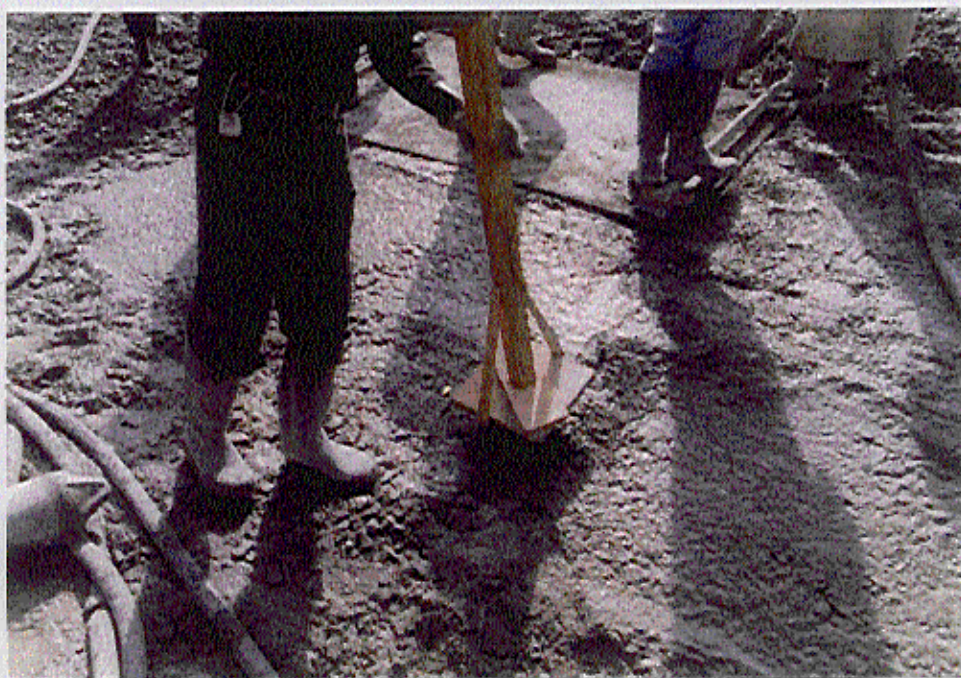
Figura 03 - Compactação por apiloamento, através de "soquete" de madeira, em concreto com agregado de \phi máx. 38 mm.
