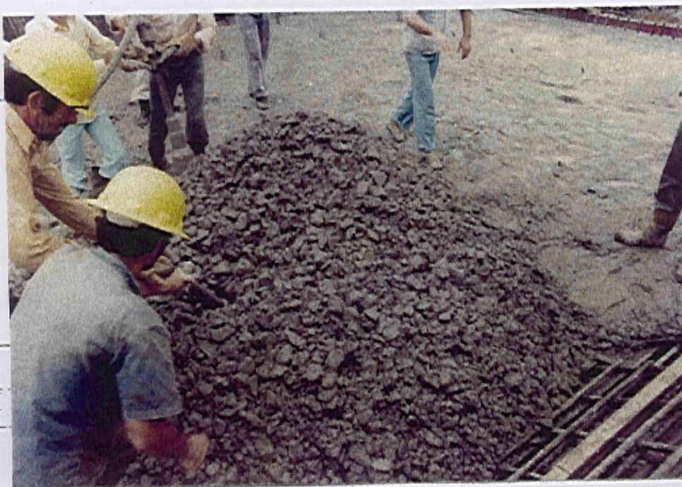
Figura 02 - Aspecto do concreto recém lançado, sem ter sido compactado.
