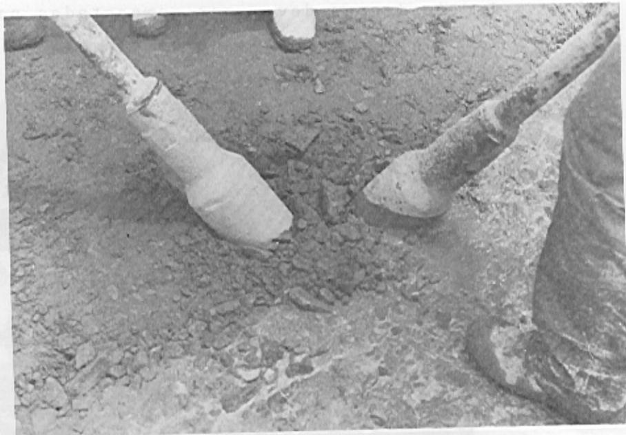
Adensamento sendo efetuado na união das duas classes de concreto, pela introdução de vibradores de imersão em ambos os concretos-Tucuruí-Brasil.
