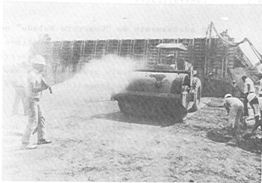
Ação de nebulizador para manter a atmosfera úmida e evitar a evaporação da água do "Concreto Rolado" - Tucuruí - Brasil.
