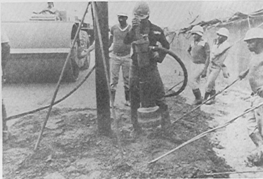
Compactador manual efetuando adensamento do "Concreto Rolado" junto a um dreno (primeiro plano), e rolo vibratório liso ao fundo - Tucuruí - Brasil.
