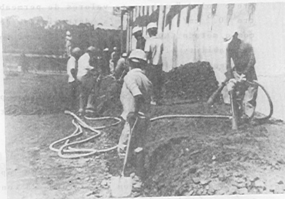
Concreto massa convencional, sendo executado junto com o "Concreto Rolado" - Eclusas de Tucuruí - Brasil.
