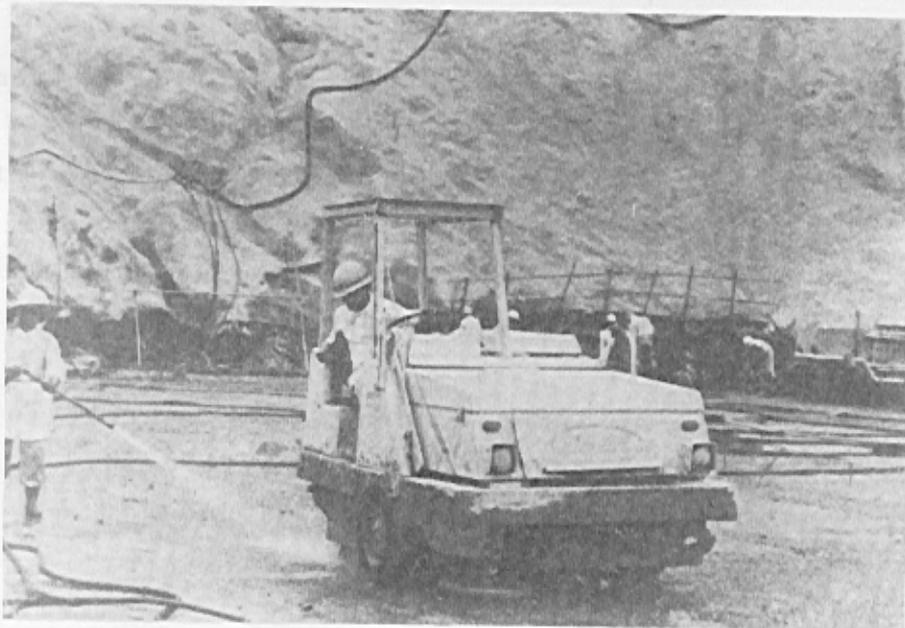
Vassoura mecânica e jatos d'água sob baixa pressão para tratamento da junta de construção - Barragem de Shimajigawa - Japão.
