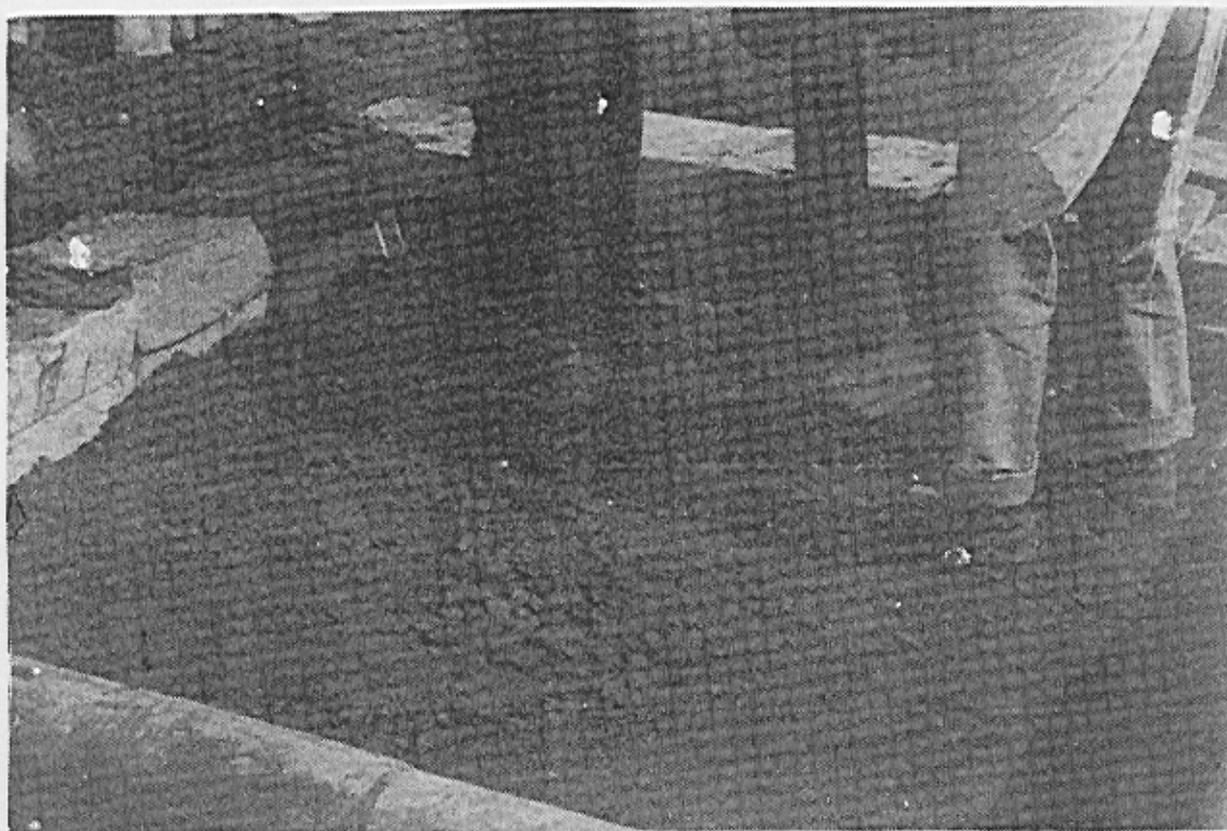
Foto 5 - Compactação do CCR com compactador portátil para posterior extração de testemunhos (Abril de 1978).
