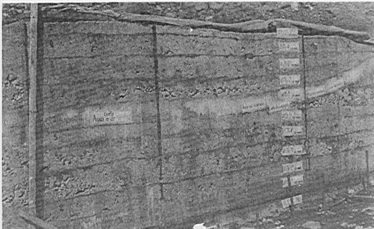
Foto 3 - Aterro experimental executado para estudos do CCR em Itaipu. Observa-se as juntas de subcamadas identificadas para extração de testemunhos (Junho de 1979).
