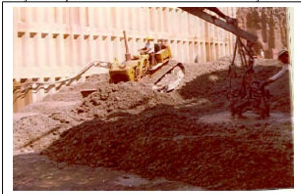
**Concreto massa lançado com Cabo Aéreo; Esoalhado com Trator de Lâmina Frontal e Adensado com Vibradores acoplados em lança de Retro-escavadora.**
