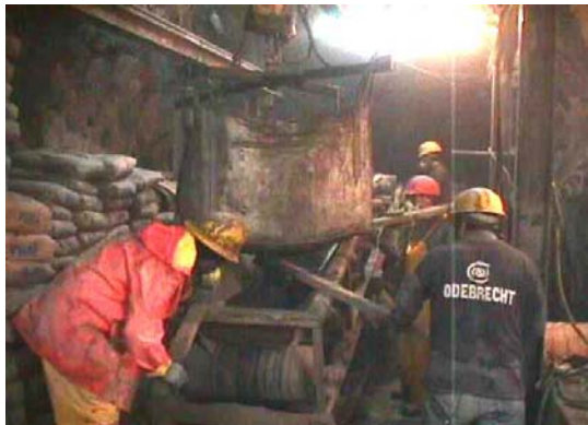
Foto 6 – Carga da correia transportadora
