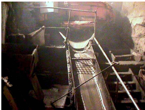
Foto 8 – Vista da canaleta com malha .Ao fundo se ve a betoneira
