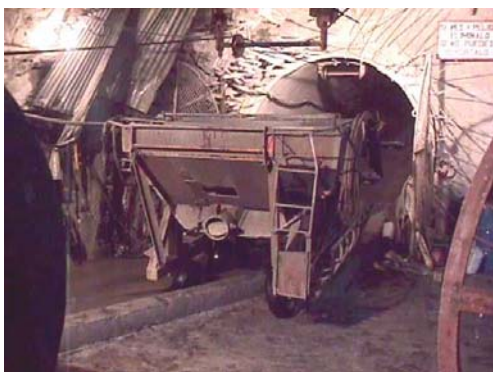
Foto 1 - Carro para transporte de concreto, pessoal e alimentação.
