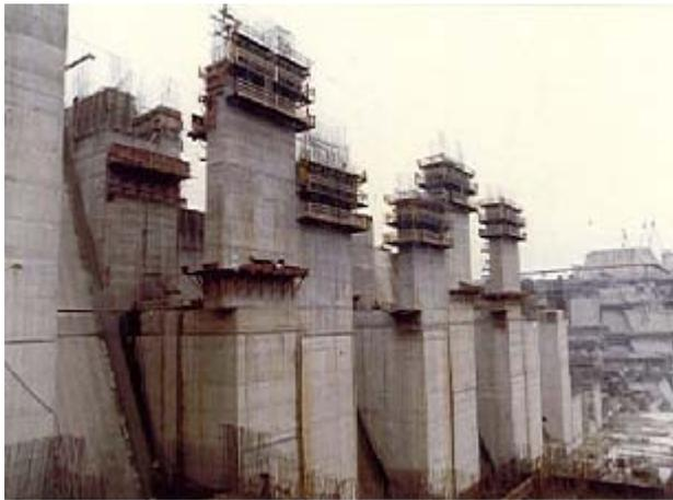
Figura 26- Encofrados de auto- elevación (1977)
