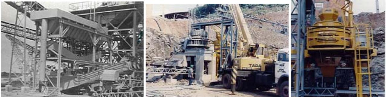
Figura 16- Uso de Tanque Clasificador de Arena para ajuste granulométrico, y el empleo de Moledores de Impacto para la producción de arena molida y arredondamiento de los granos de arena (años 70)
