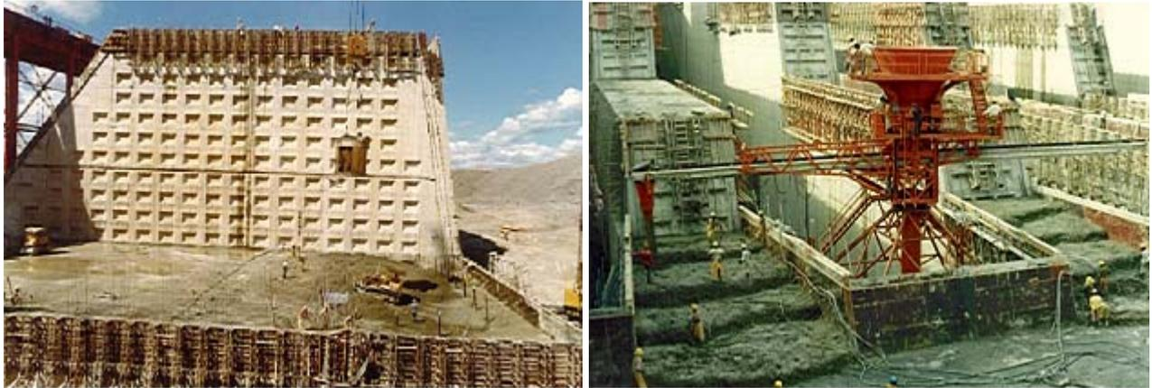
Figura 11- Hormigón de Masa, sin armadura de piel en las caras
