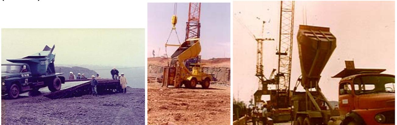
Figura 19- Sustitución de los Camiones Báscula de Descarga Baja, por los de Descarga Alta, reduciendo el ciclo de las grúas (años 70)
