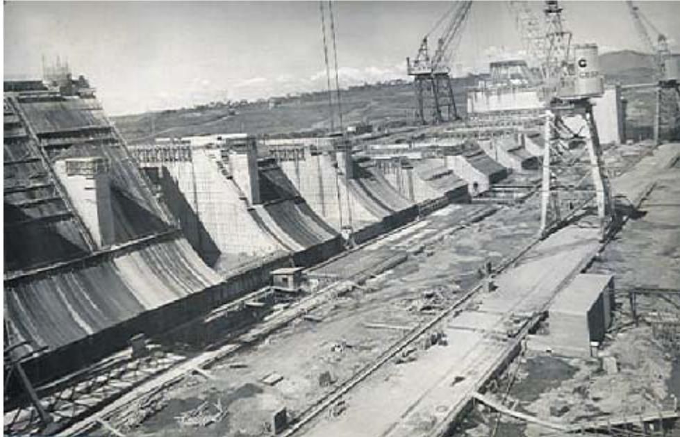
Figura 08- Superficie de hormigón del Vertedero de Ilha Solteira, sin empleo de armadura (1970)
