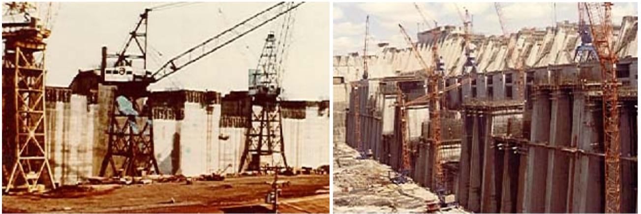
Figura 17- La sustitución de las Grúas tipo Portuario (de Mesa Alta) por las Grúas de Mesa Baja (mediados de 1970)
