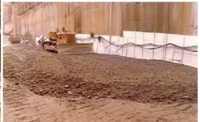
Figura 30- Estudios y aplicaciones iniciales - experimentales del CCR (Itaipu- 1976)
