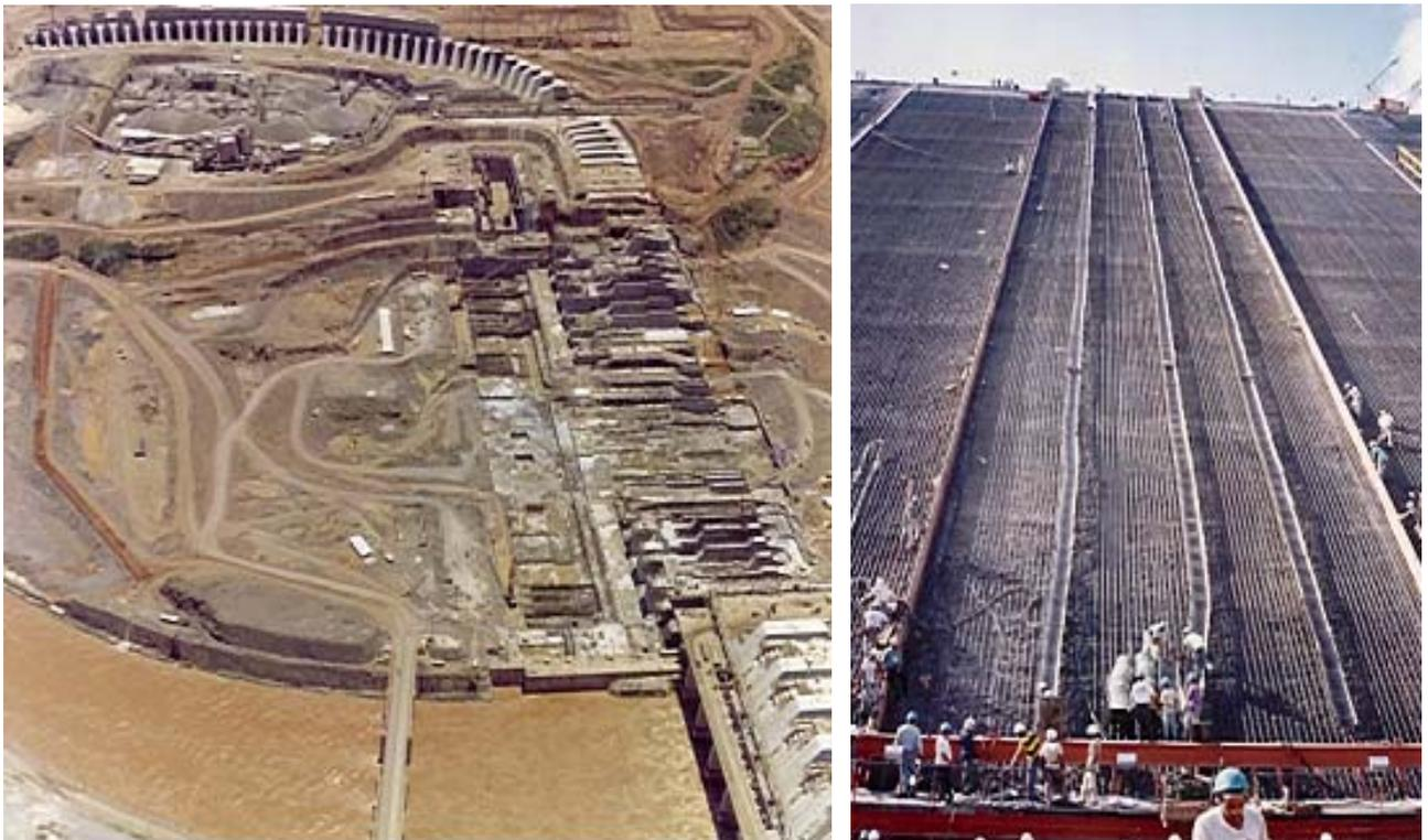
**Figura 04 - Construcción de Itaipu y de la cara de la presa de Enrocado con Cara de Hormigón, de Xingó**
