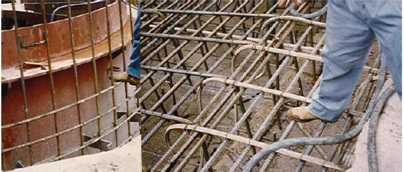
Figura 32- Empleo de armadura en zona del Tubo de Aspiración y en Secundario de la Caja de la Turbina
