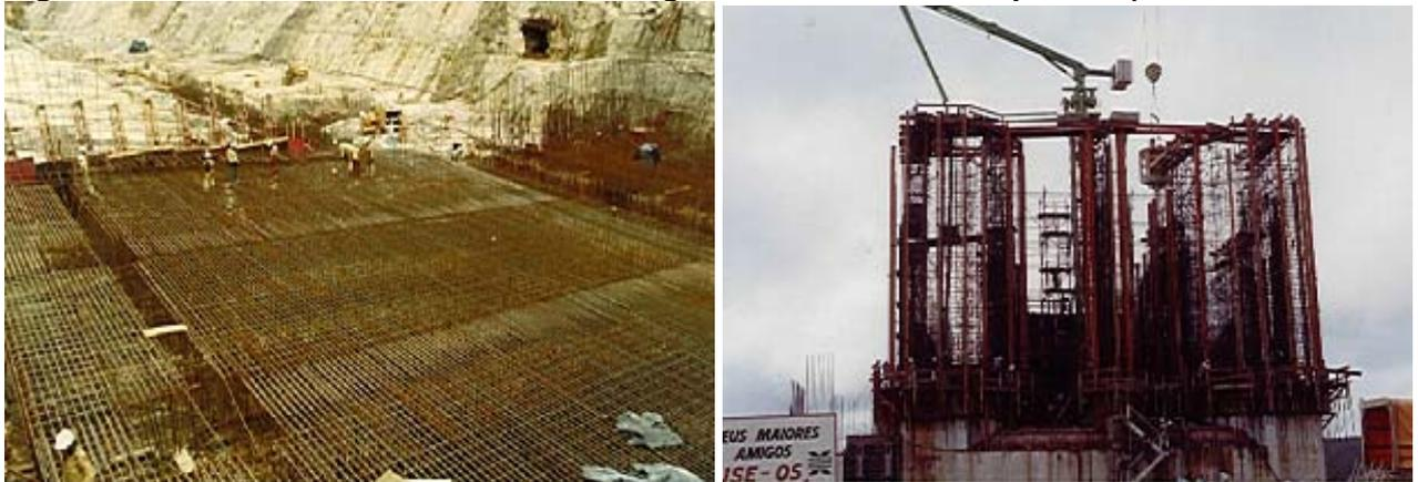
Figura 23- Uso de armadura pre ensamblada
