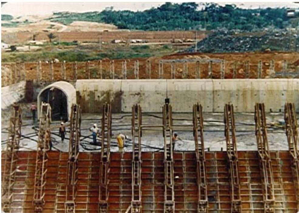
Figura 33- Ausencia de armadura en las galerías
