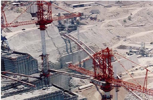
**Figura 35- Sistema de Bandas Transportadoras para transporte y colocación del hormigón**
