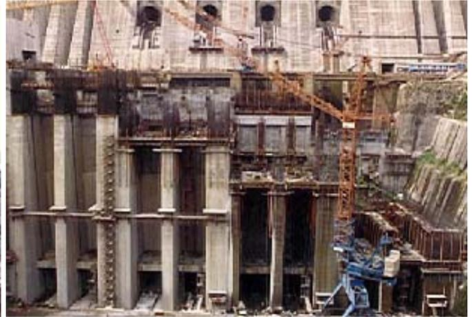
Figura 27- Encofrados deslizantes en Casa de Maquina (1980)
