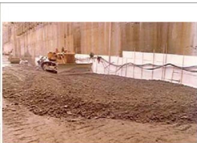
**Figura 30- Estudo e aplicação de Concreto Compactado com Rolo (Itaipu- 1976)**
