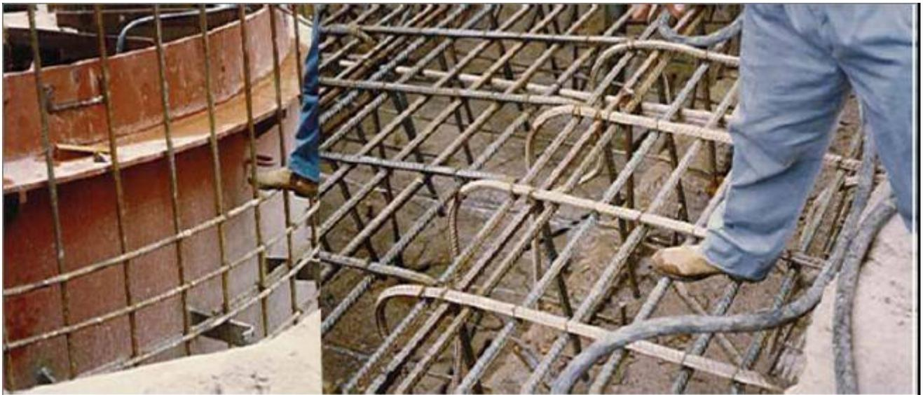
**Figura 32- - Emprego de armadura na região do Tubo de Sucção e em Secundários da Caixa Espiral da Turbina.**
