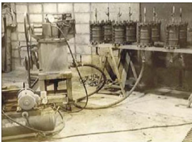
**Figura 29- Estudo e adoção de concreto com agregado pré-colocado (Ilha Solteira- 1973)**
