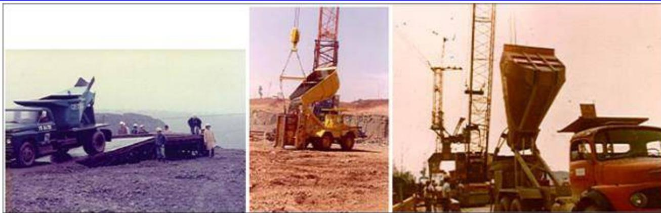
**Figura 19- Substituição dos caminhões Basculantes de Descarga Baixa, pelos de Descarga Alta, reduzindo o ciclo dos Guindastes (anos 70)**
