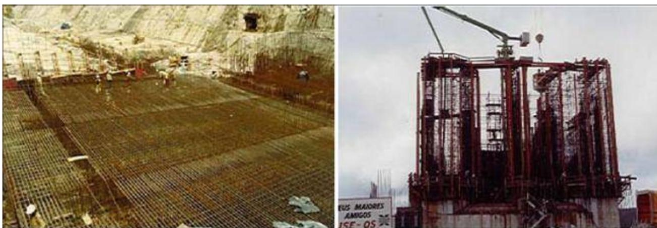
**Figura 23- Uso de armadura pré- montada**
