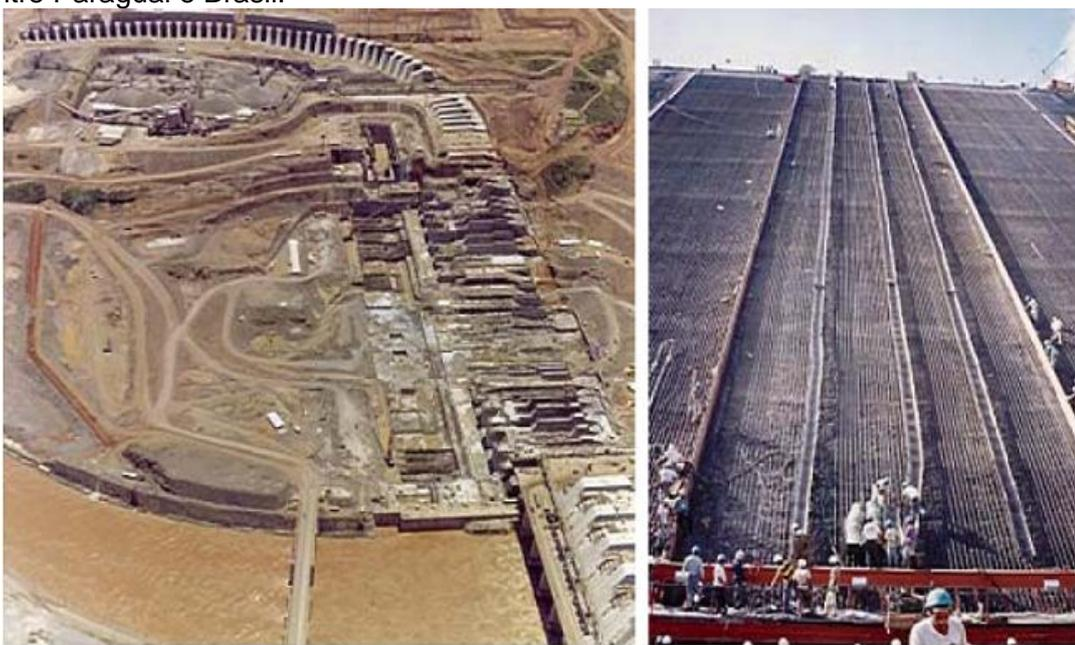
**Figura 04 - Construção de Itaipu e a Face de Concreto da Barragem de Enrocamento da Barragem de Xingó**
