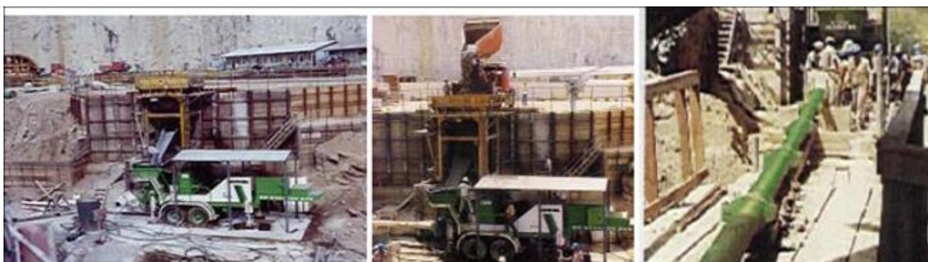
**Figura 21- Emprego de Bombas para concreto com Tubulação de Diâmetro elevado, possibilitando aumentar o  $D_{max}$  do agregado (80mm) e a conseqüente redução do consumo de aglomerante (meio dos anos 80)**
