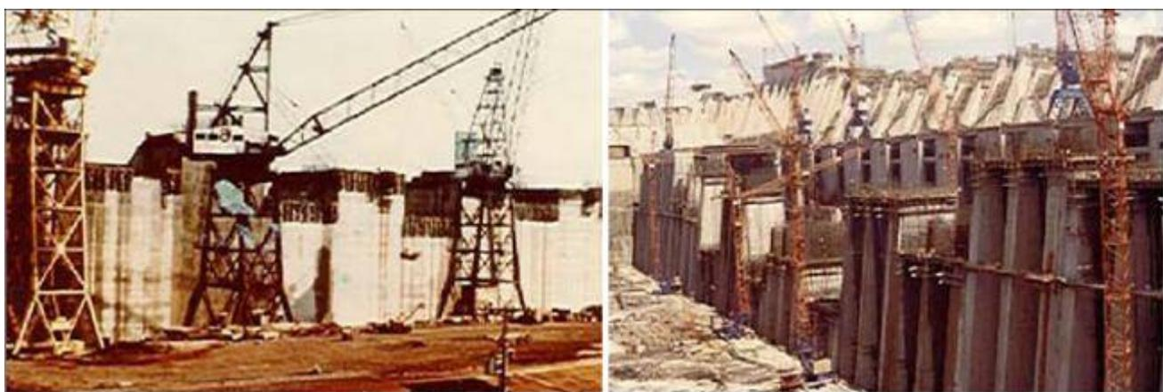
**Figura 17- Substituição dos Guindastes Tipo Portuário pelos Guindastes de Mesa Baixa (meados de 1970)**
