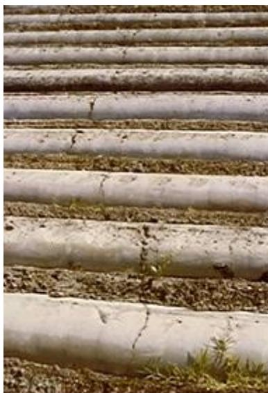
Figura 06—Aspecto de Fissura em Solo Cimento da Proteção de Taludes na Barragem de Martin<sup>[07]</sup>
