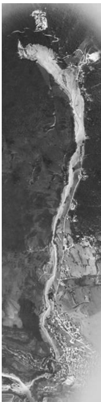
Vista Aérea após a Ruptura
