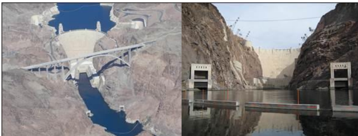
FIGURAS 1 – Vistas da Barragem da Hidrelétrica de Hoover, construída durante a década de 30 nos Estados Unidos, caracterizando-se pela Qualidade e Durabilidade.
