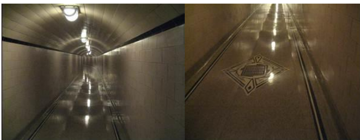
FIGURAS 2 – Vistas de Galerias internas no Corpo da Barragem da Hidrelétrica de Hoover, evidenciando a Qualidade.
