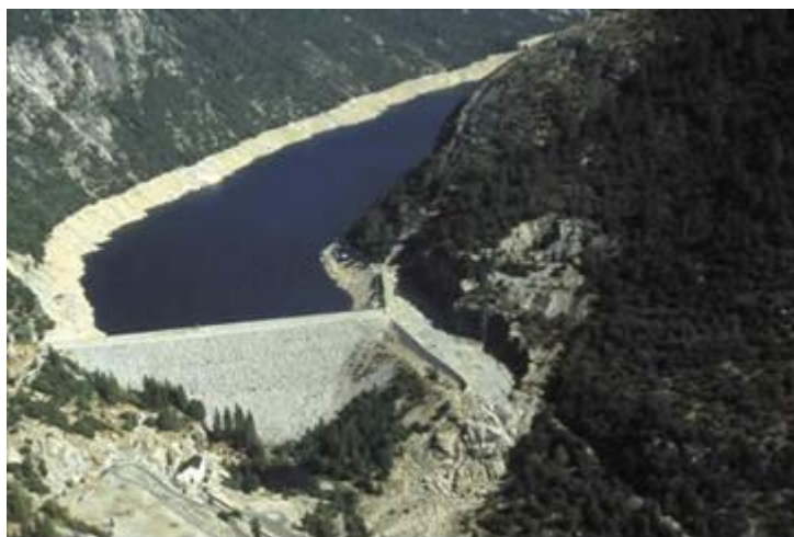
FIGURA 8– Barragem de Salt Spring cuja face rompeu várias vezes e foi reparada em 2005, com a aplicação de geomembrana flexível
